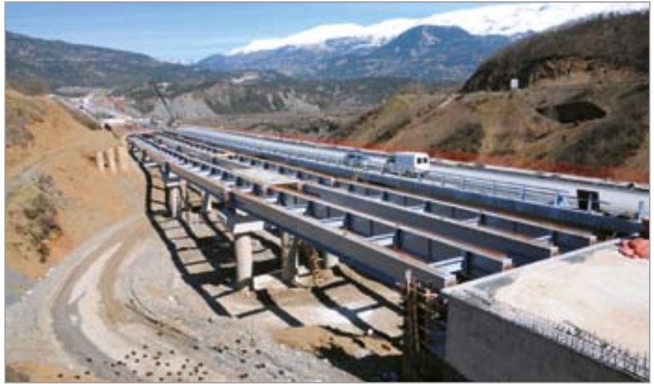
Γέφυρα T8, Εγνατία οδός (ΑΕΓΕΚ κατασκευαστική Α.Ε.)
