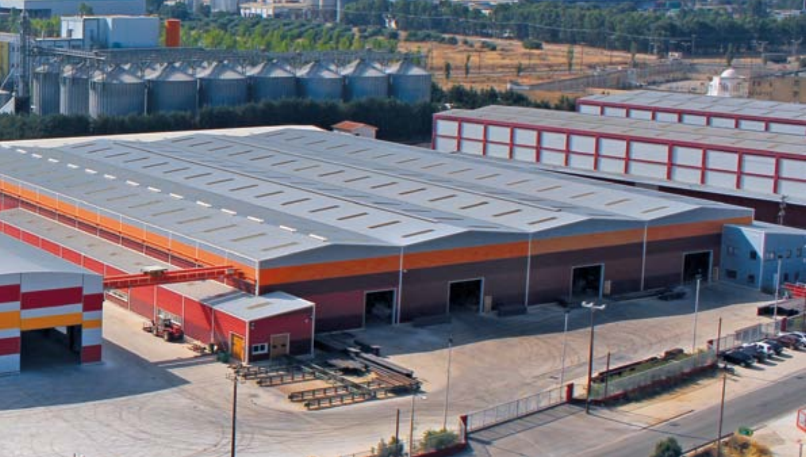
Άποψη εξωτερικών εγκαταστάσεων εργοστασίου
