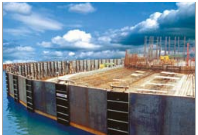
Φράγμα κατασκευής πιλώνων (Κ/Ε Γέφυρα)
