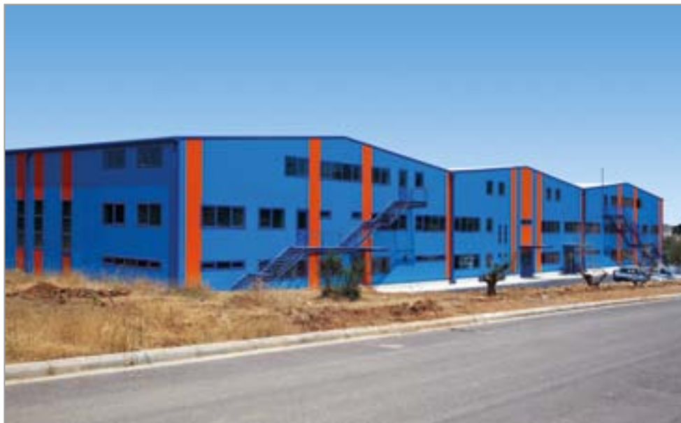
Μονάδα κατασκευής εργαλειοθηκών και λοιπών μεταλλικών εξαρτημάτων (Σαραστής - Victoria S.A.)
