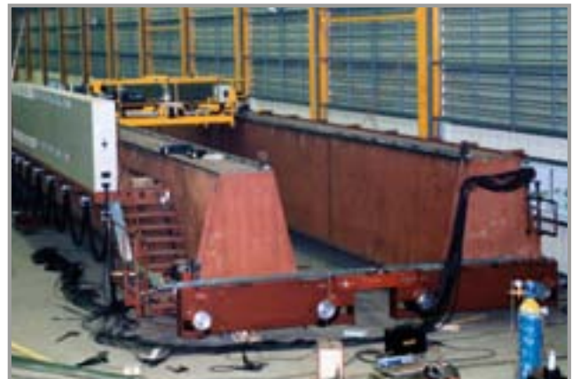
Κατασκευή box γερανογέφυρας
