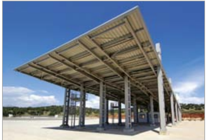
Πύλη εισόδου λιμανιού ΝΑ.ΒΙ.ΠΕ (Κ/Ε Αστακός Τέρμιναλ)
