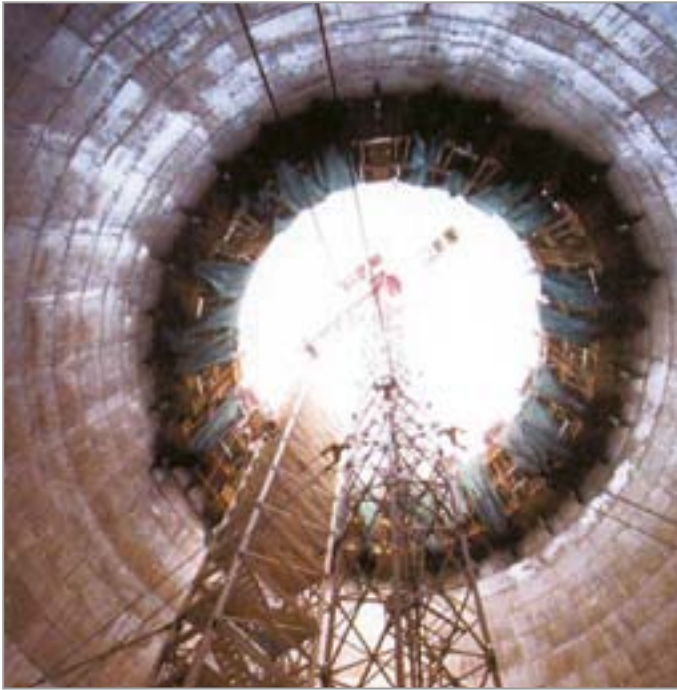
Κλιμακοστάσιο στο εσωτερικό πυλώνα (Κ/Ξ Γέφυρα)
