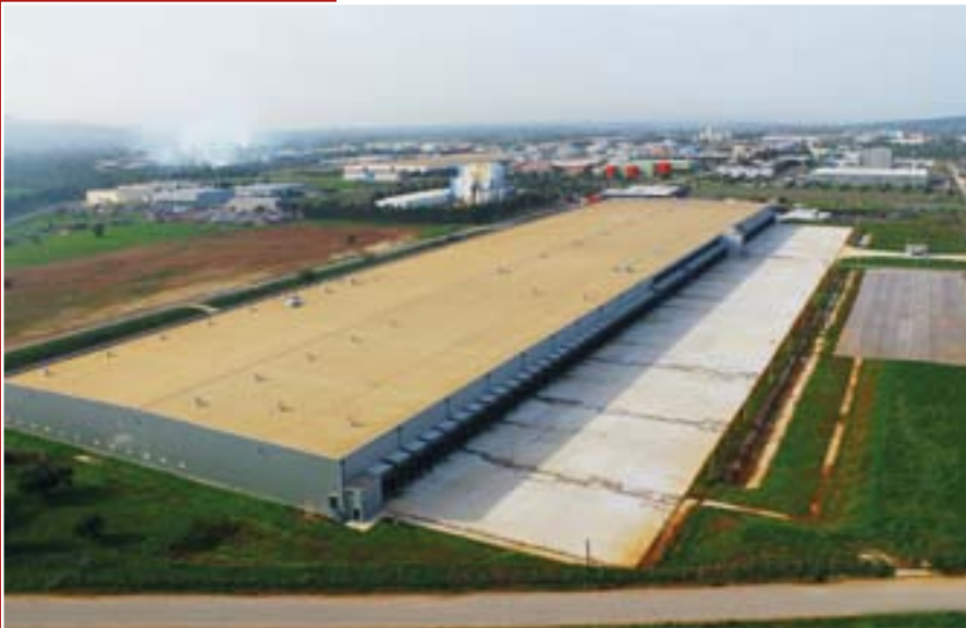
Πρότυπο κέντρο διανομής Πατρών, επιφάνειας 35.000m 2 , Aldi, (Alpine Bau GmbH)
