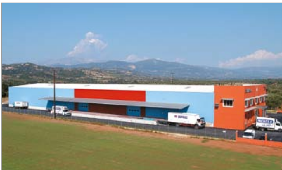
Κέντρο αποθήκευσης & διανομής προϊόντων (Ζερβας Α.Ε.)
