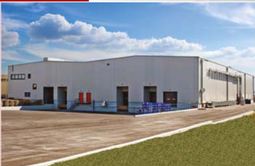
Βιομηχανική αποθήκη χρωμάτων - Βιβεχρωμι Α.Ε. (Ακτωρ Ατε)
